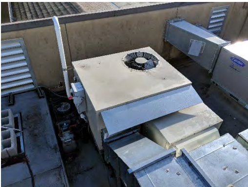
SITE A C-RTU
